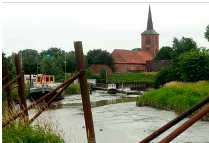
Am Asseler Hafen beginnen jetzt die Arbeiten an den Spundwänden und am Hafensplatz.
