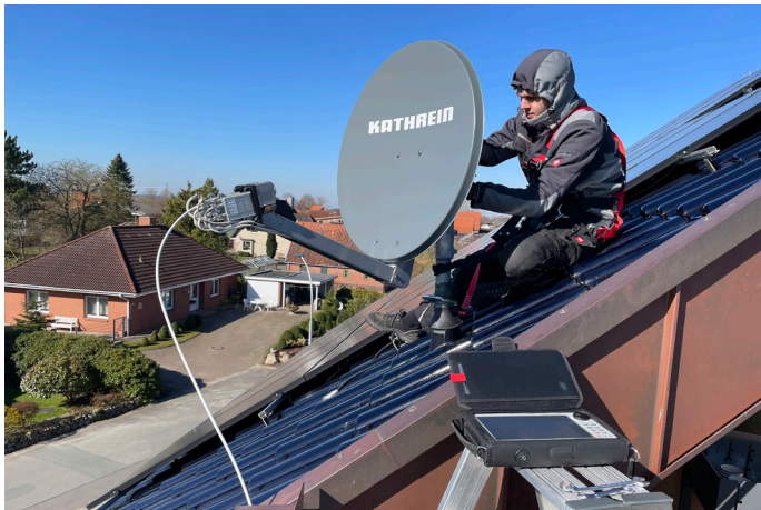
IT-Systemelektroniker Gerrit Elfers ist ein schwindelfreier Experte und installiert hier eine SAT-Anlage auf einem Hausdach.
